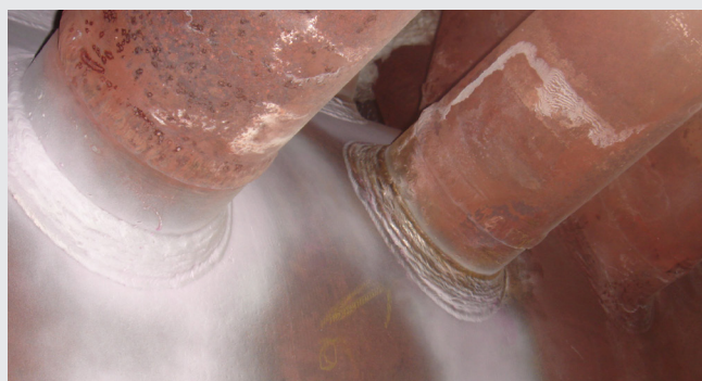
Inspection de capacités / réservoirs
